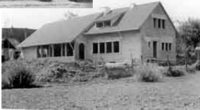
Bild unten: neuer Kindergarten im Rohbau 1957
